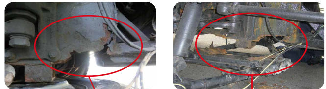
主要骨格部位の腐食による穴あき等は、堅ろうではないとして保安基準不適合
